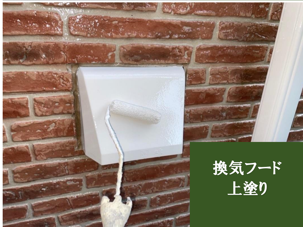
換気フード 中塗り
