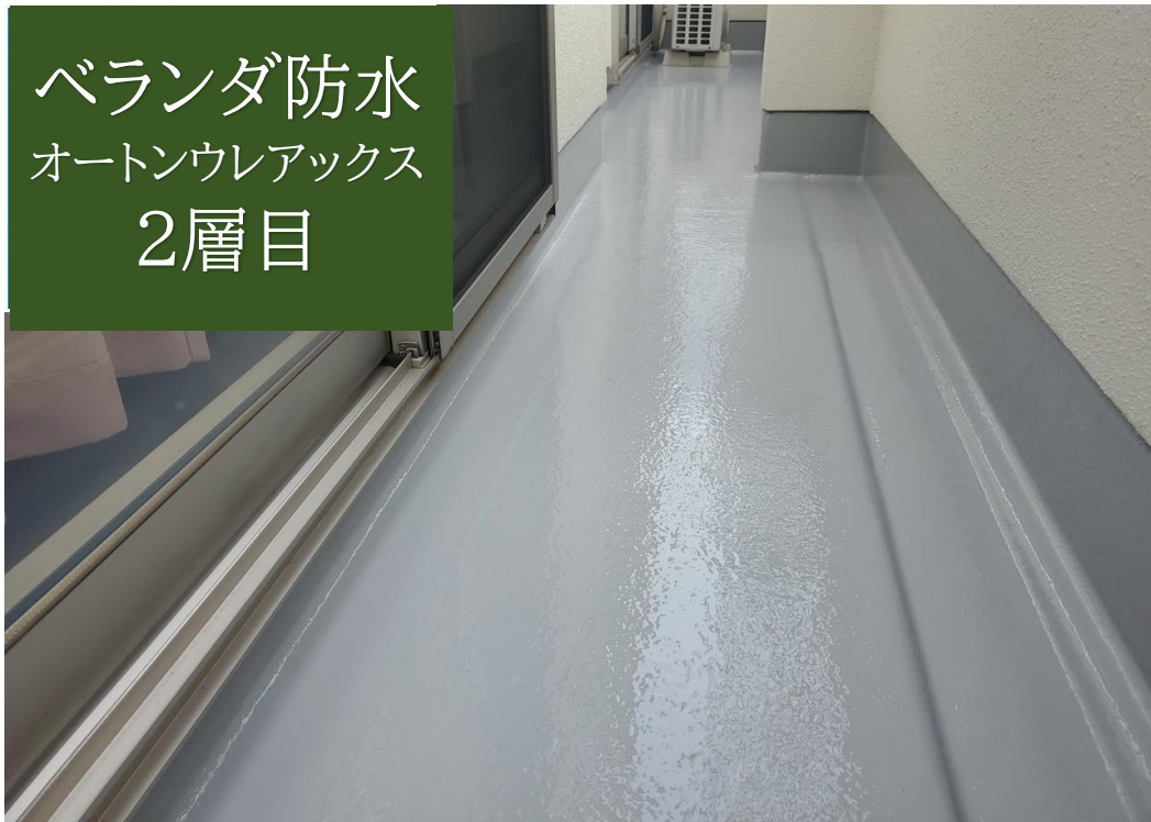
ベランダ防水 オートンウレアックス 2層目
