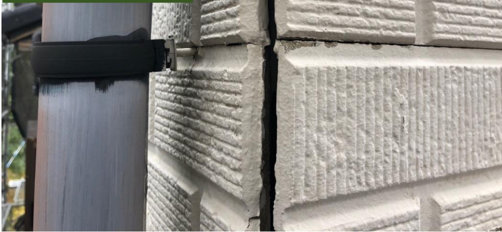
外壁下部補修 ビス止め前
