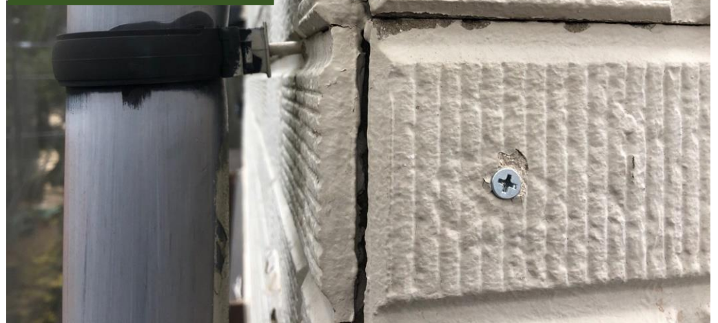
外壁下部補修 ビス止め完了
