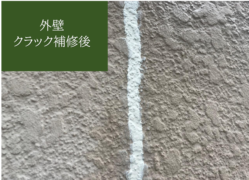
外壁 クラック補修後
