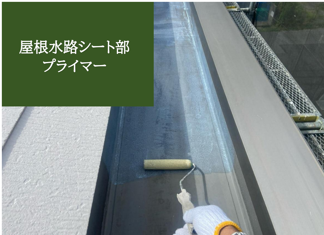
屋根水路シート部 シートトップ 上塗り
