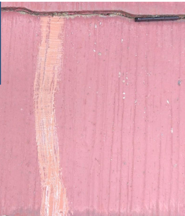
屋根クラック 補修後
