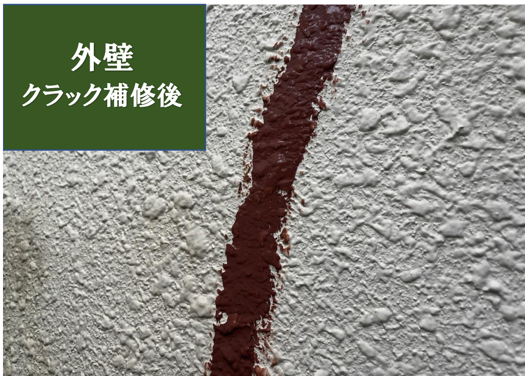
外壁 クラック補修後
